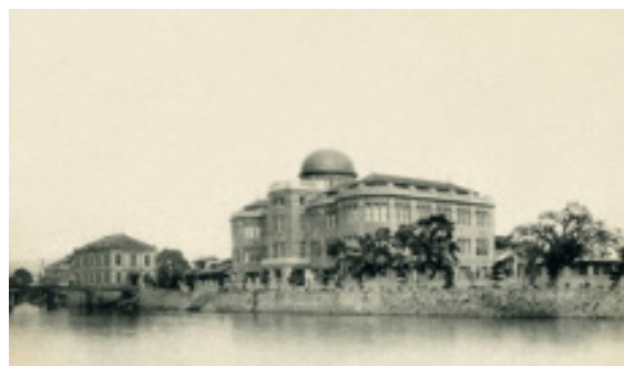
1915年 広島県産業奨励館（原爆ドーム）
